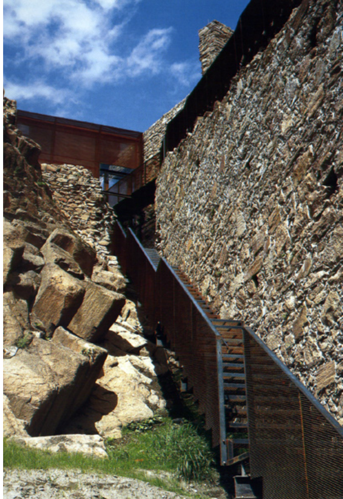
Werner Tscholl: Castel Firmiano, Bolzano 2006
