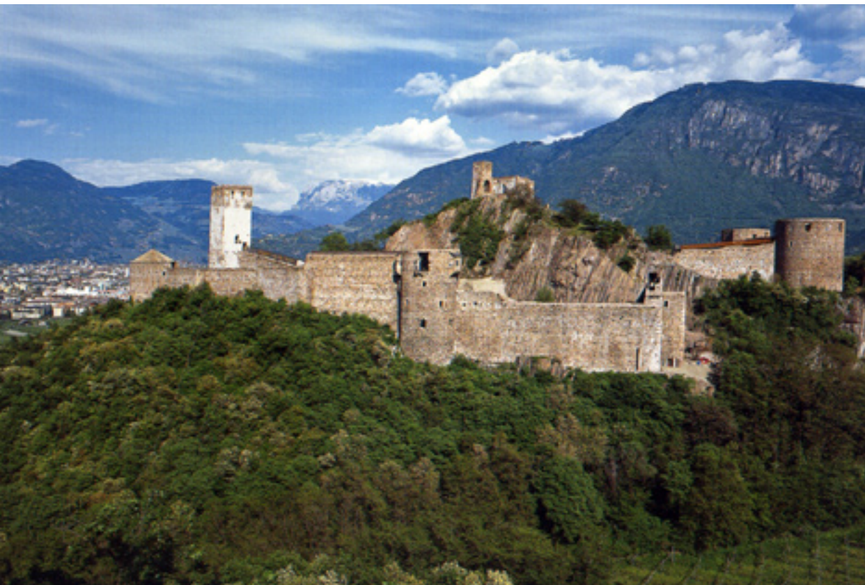
Werner Tscholl: Castel Firmiano, Bolzano 2006
