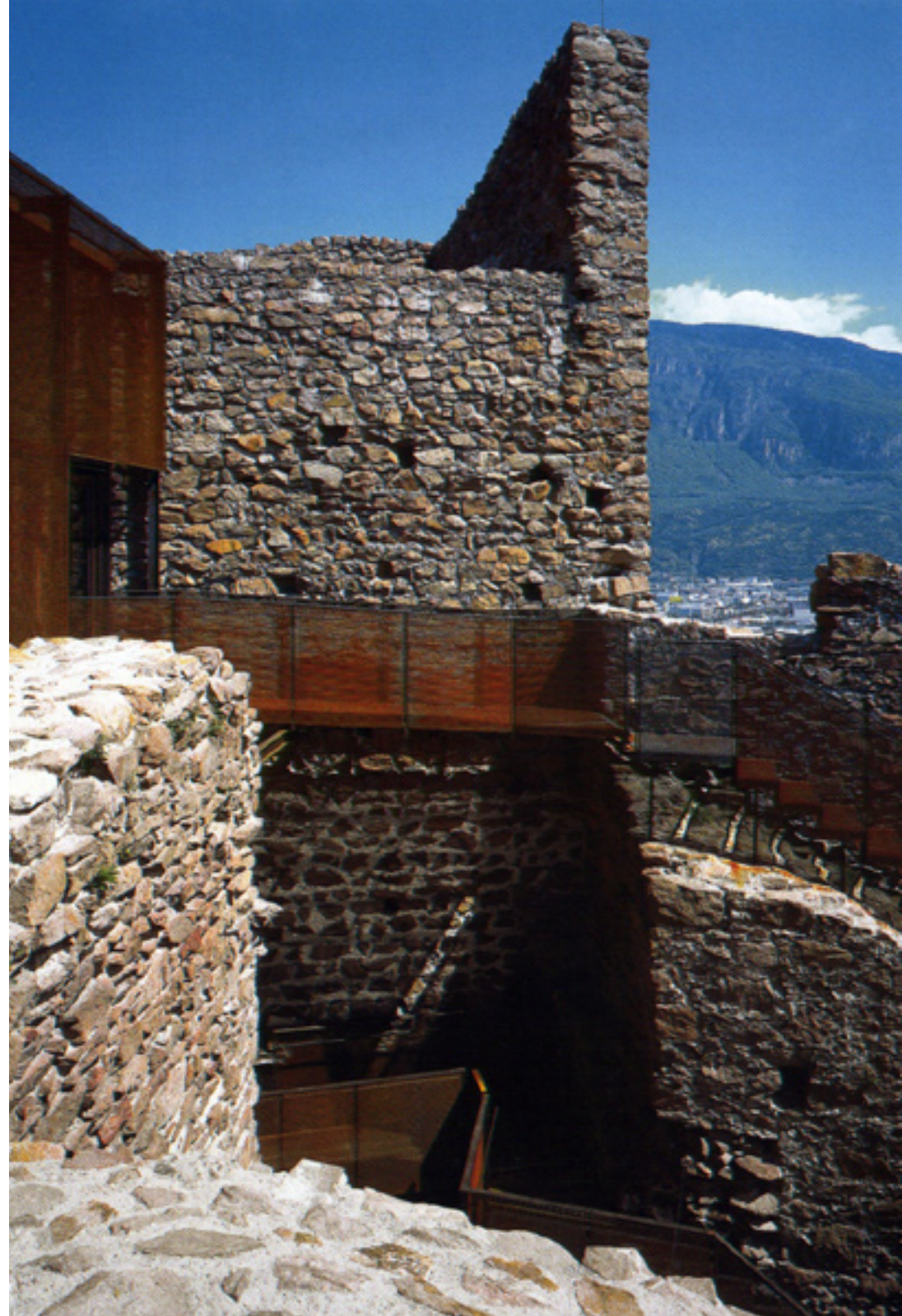
Werner Tscholl: Castel Firmiano, Bolzano 2006
