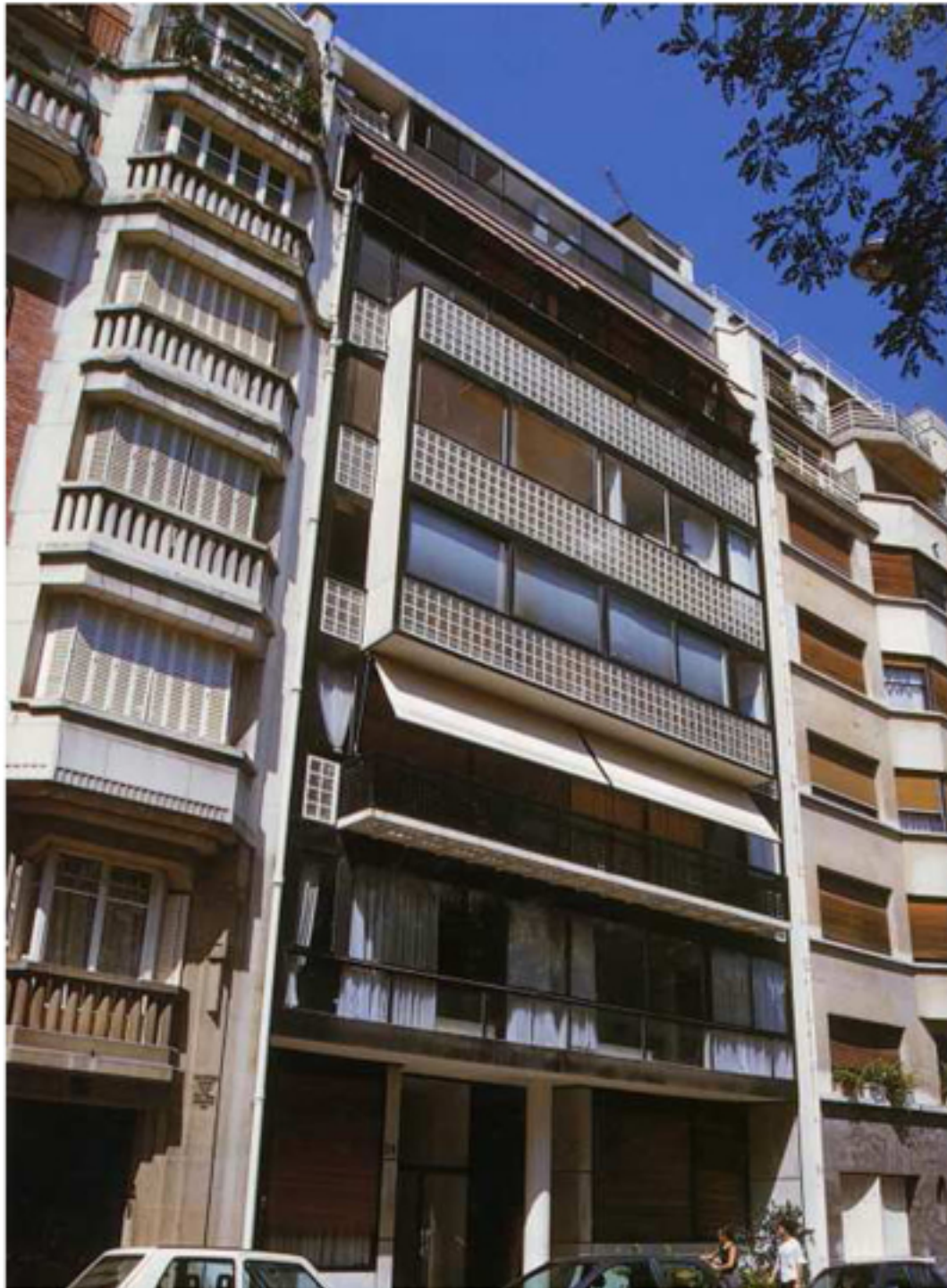
Le Corbusier, Edificio a Porte Molitor, Parigi 1933
