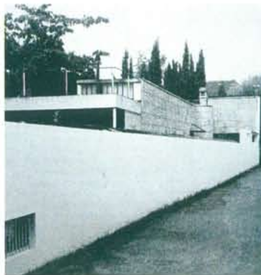
Nel mio progetto è riproposta la variazione d'altezza del recinto che in questo modo assume funzioni differenti (seduta, svago, contenimento..).
